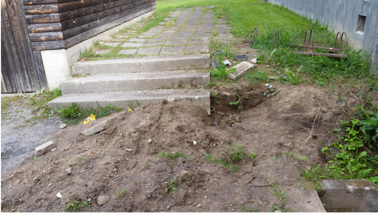
Bakom röda huset har markarbeten utförts, men inte slutförts. Olycksrisker vid stöj och lek.
